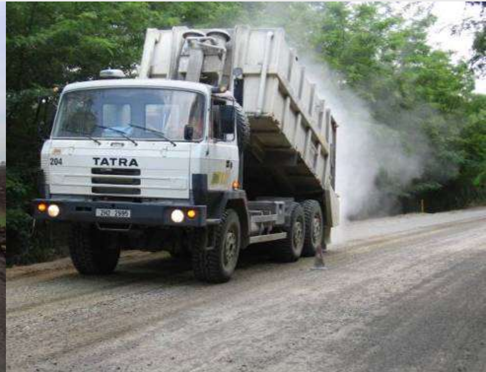
Cementterítés fokozatmentesen állítható cellás adagolóval
