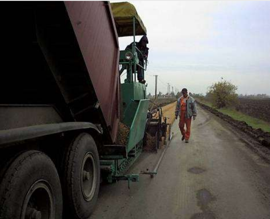
Kiegészítő kőanyag terítése finisherrel
